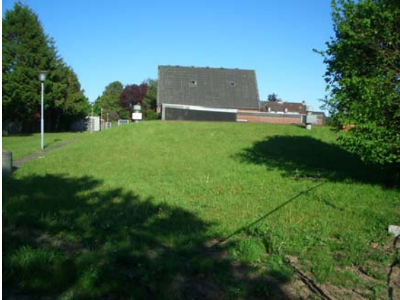
Abb. 4: Vorh. Wasserwerkgelände von Süden
