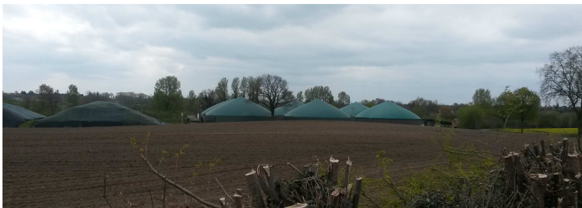
Abb. 5: Blick auf die Biomasseanlage von Norden
