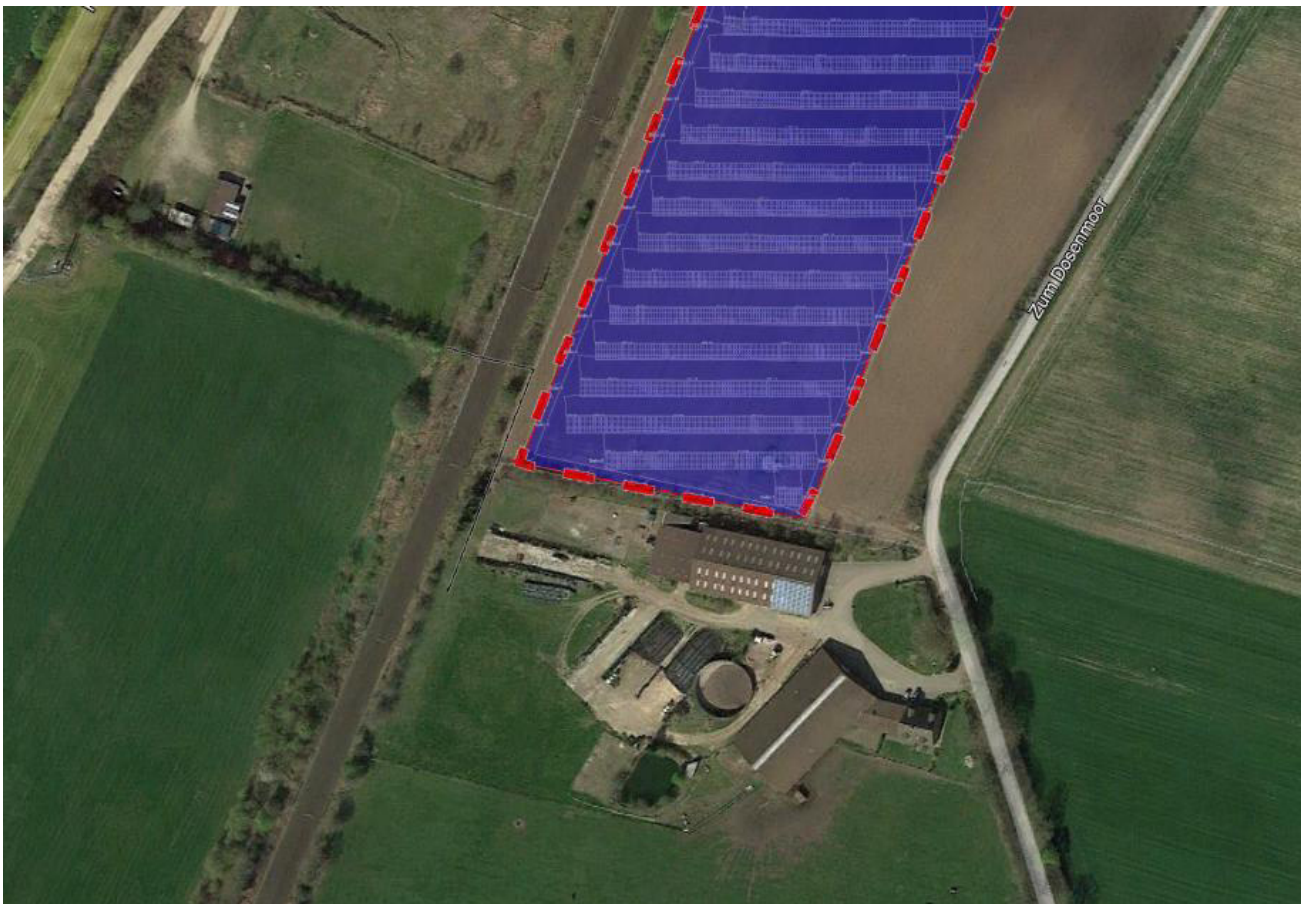
Bild 2.2.1: Gebäude südlich der PV Anlage (Quelle: Google Earth/SolPEG)
