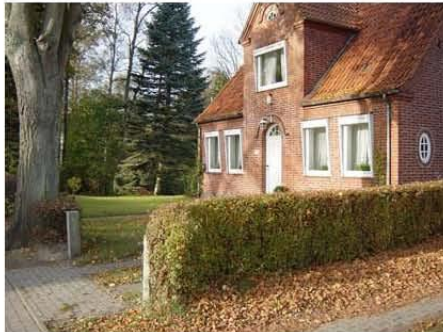
Abb. 1: Ansicht von der Holstenstr.
